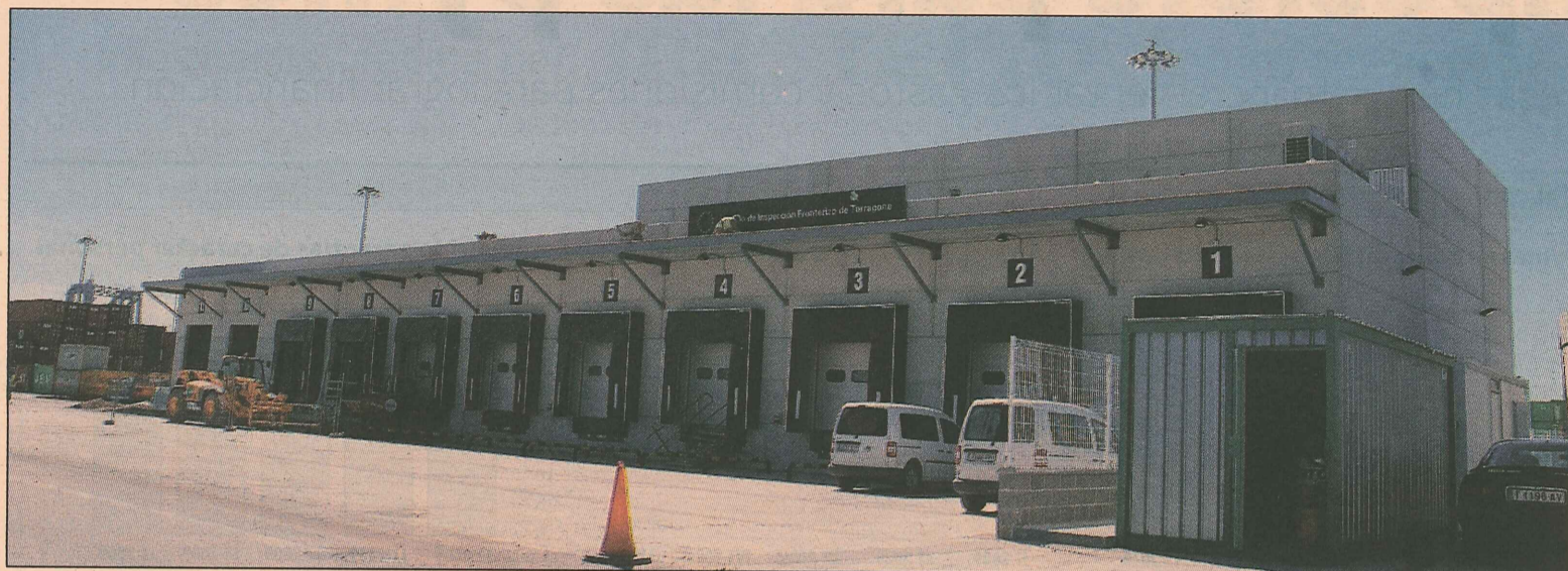
En la imagen, las nuevas Instalaciones Fronterizas de Control Sanitario de Mercancías, en la entrada del muelle de Andalucía. FOTO: DT
