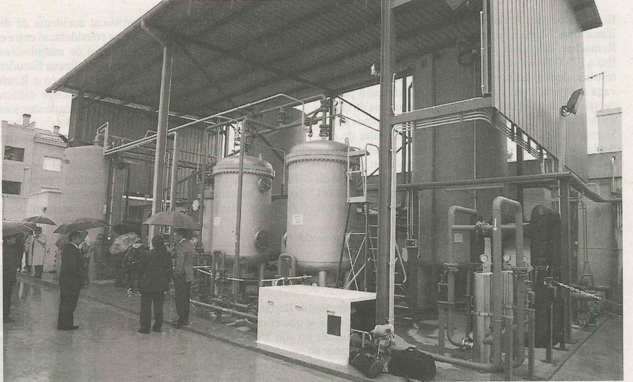
La planta elimina els nitrats de l'aigua transformant-los en gas de nitrogen. / JOSÉ CARLOS LEÓN
